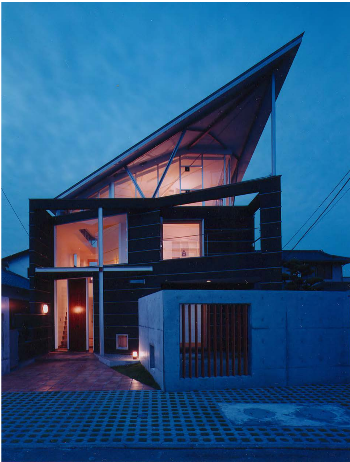
TAM-TAM HOUSE (静岡県沼津市)
